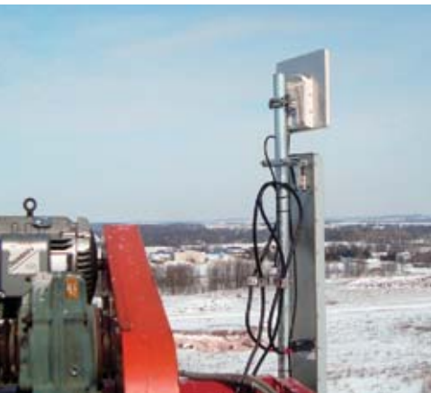
WiMAX backhaul, USA
